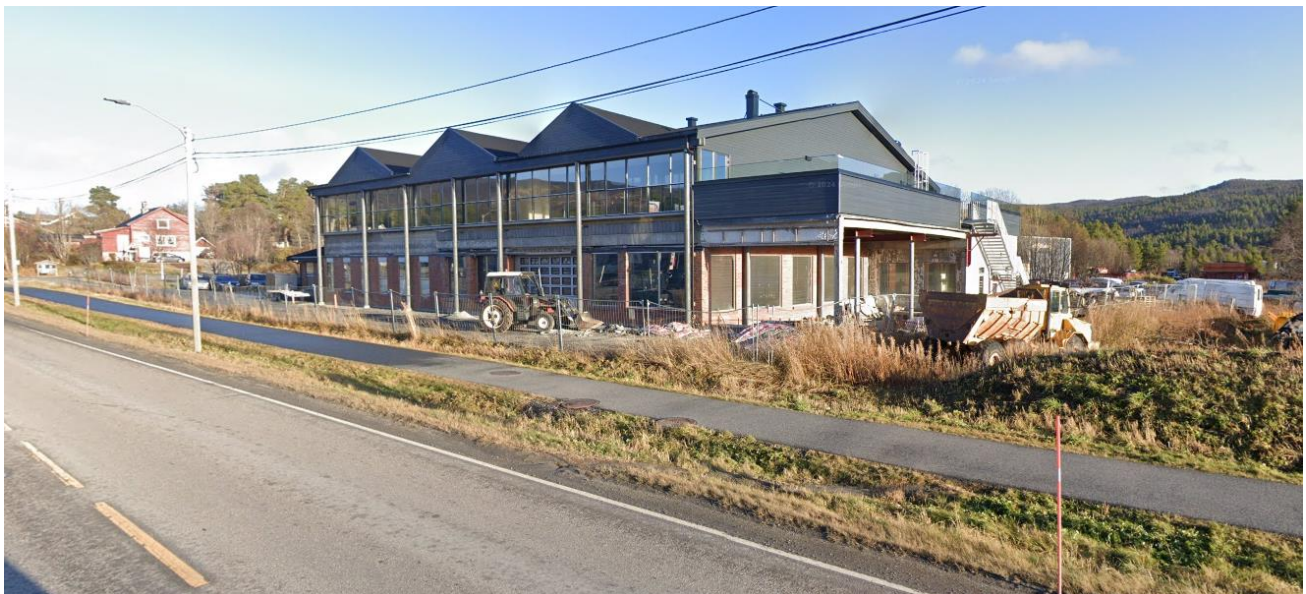
Figur 1-2 Gatebilde av Lienvegen 89-91 sett fra rv. 7 (kilde: google streetview fra oktober 2024).
