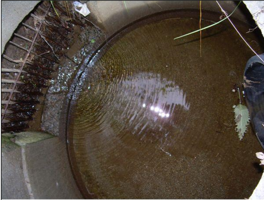
Figur 6: Bekkeinntak med rist. Betongkum, DN1200. Overvann føres til Ø400 PVC ledning.
