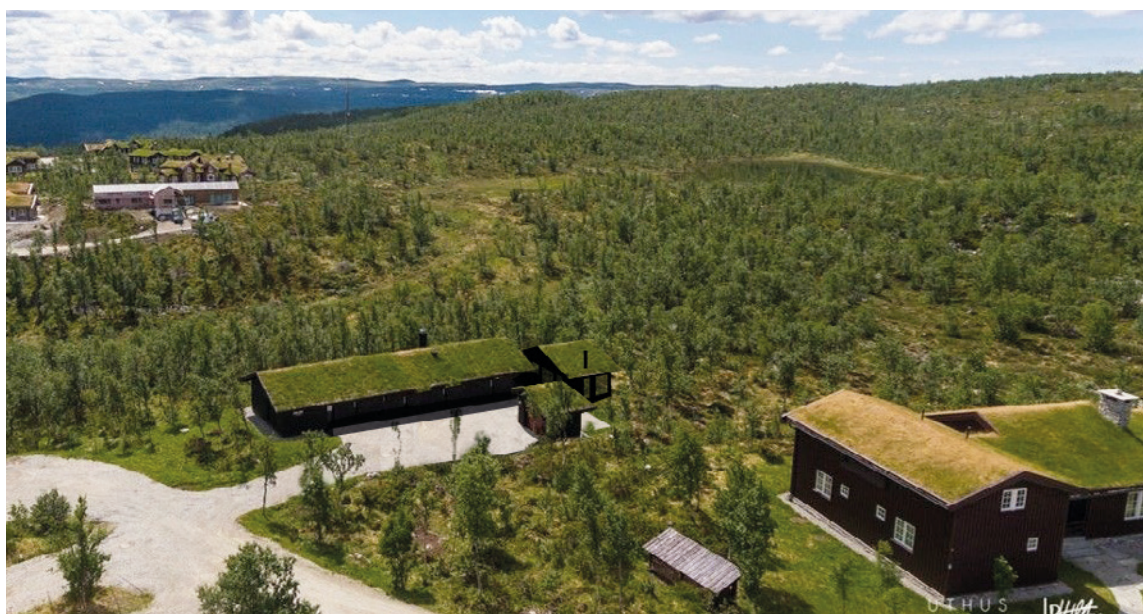
Tunet utan anneks, med tilbygg og skibod
