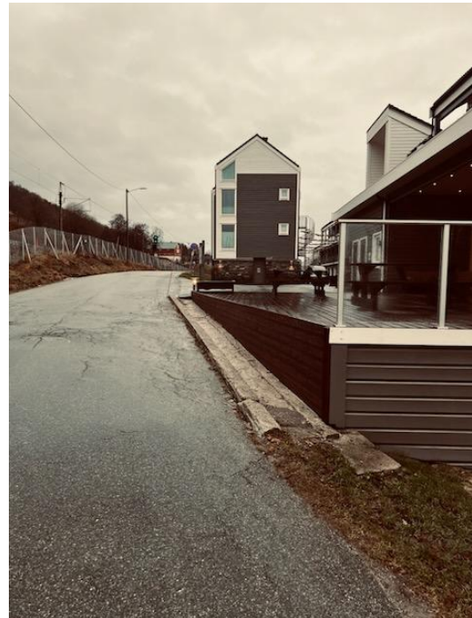
Figur 5-2. Bildet viser situasjonen ved terrassen i nord etter terrassen er kuttet og steingjerdet er fjernet. Foto: ustedalen Hotell AS.
