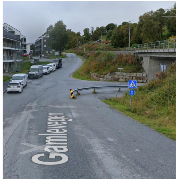
Figur 5-7. Eksisterende situasjon med autovern.
