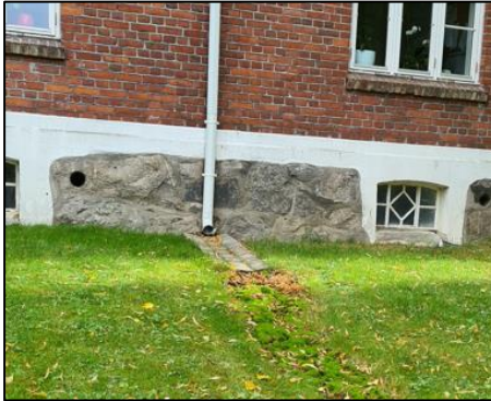
Figur 12: Takvann ledes ut på terreng/grøntområde. Foto: Jan Inge Rygh.
