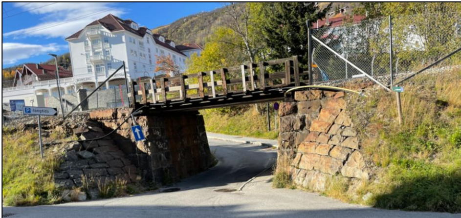
Figur 3-41 Dagens envegsregulert undergang under Bergensbanen ved Dr. Holms (foto: Sweco AS).
