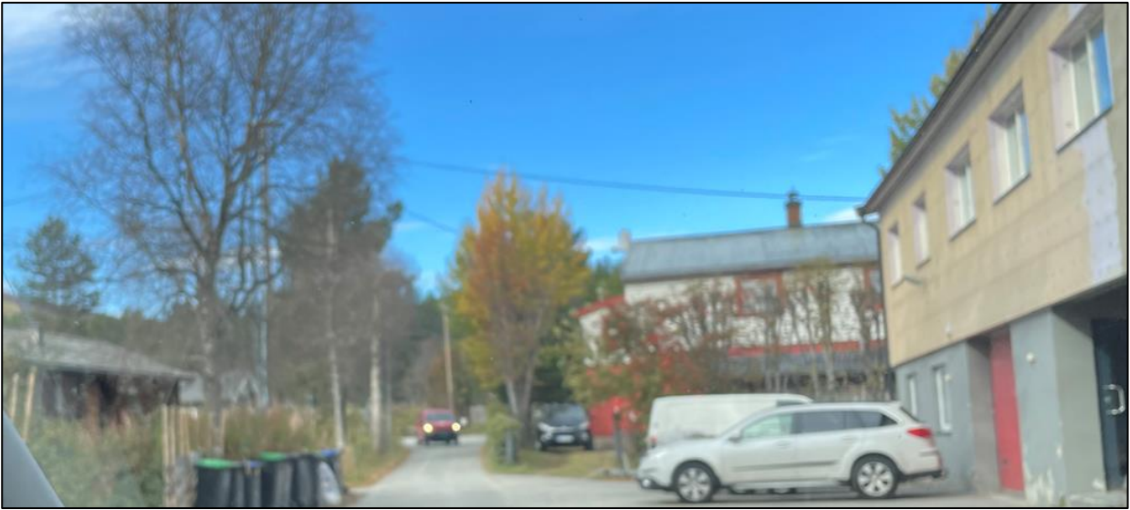
Figur 3-48 Lundvegen sett fra næringseiendom mot rv.7 (foto: Sweco AS). Bilen i bakgrunnen viser hvor smal Lundvegen er.
