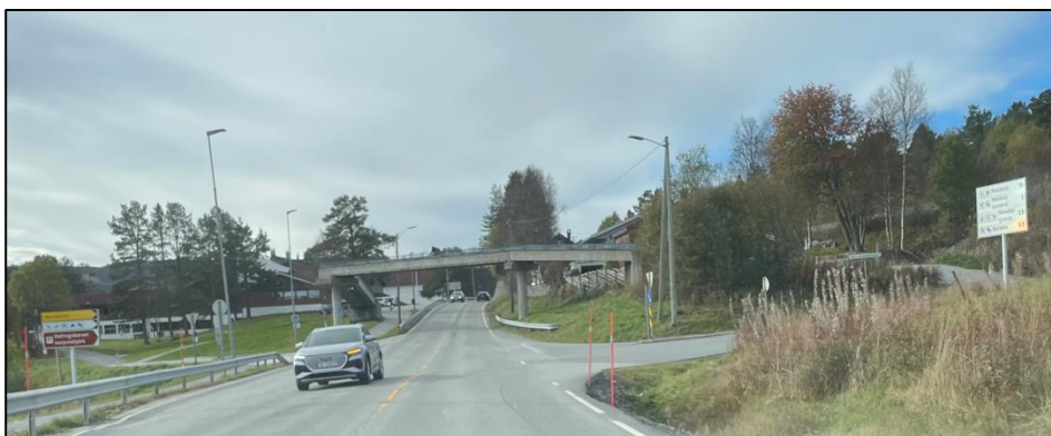
Figur 3-12 Bilde langs rv.7 sett mot vest ved Nye Havsdalsvegen (til høyre). Foto Sweco AS.
