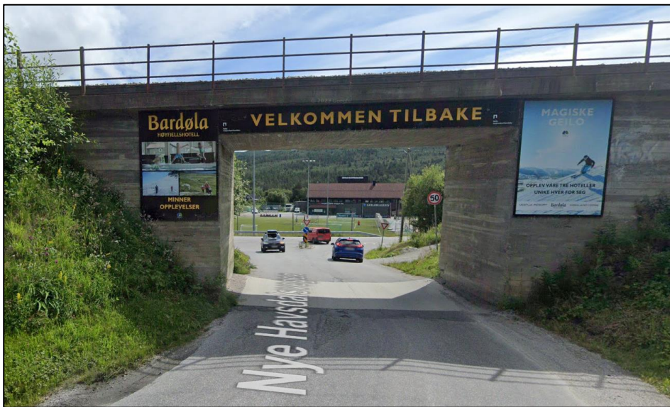
Figur 3-11 Undergangen under Bergensbanen sett sørover mot rv.7 fra Nye Havsdalsvegen (kilde: Google Street View).
