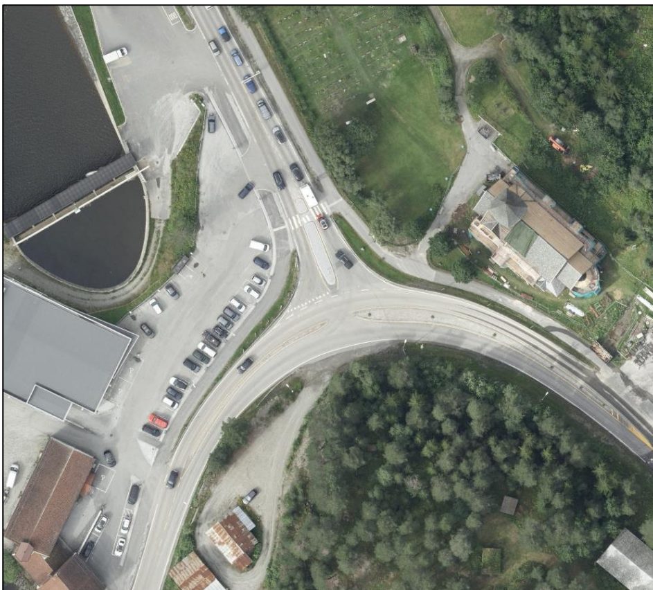
Figur 3-4 Flyfoto av T-krysset mellom fv.45 X rv.7 (kilde Norgebilder fra 10. august 2023).
