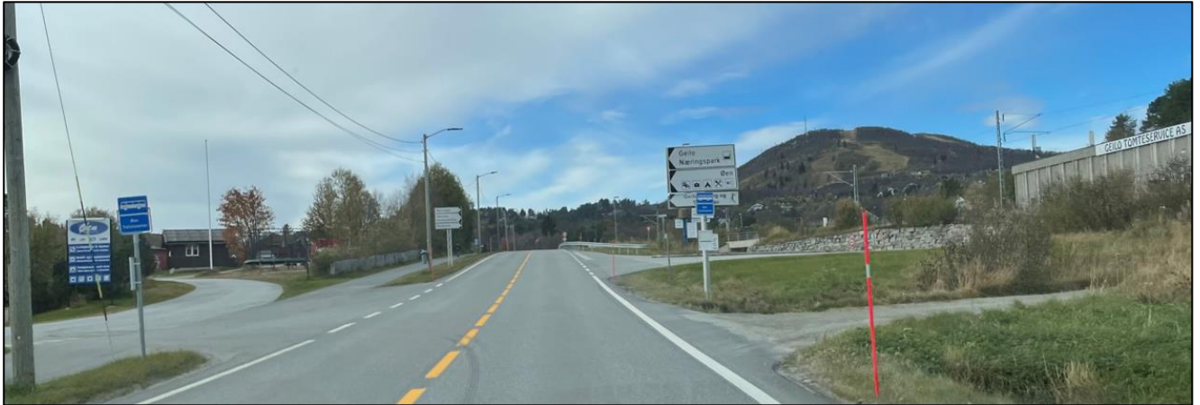
Figur 3-9 Bilde sett mot T-krysset med Øyovegen sett fra øst (foto: Sweco AS)
