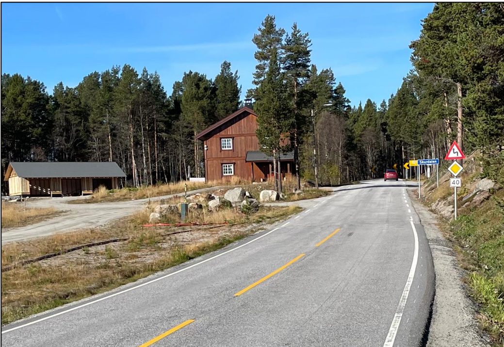
Figur 3-31 Fv.40 Skurdalsvegen sett fra sør med avkjørsel til venstre mellom steinene (foto: Sweco AS).
