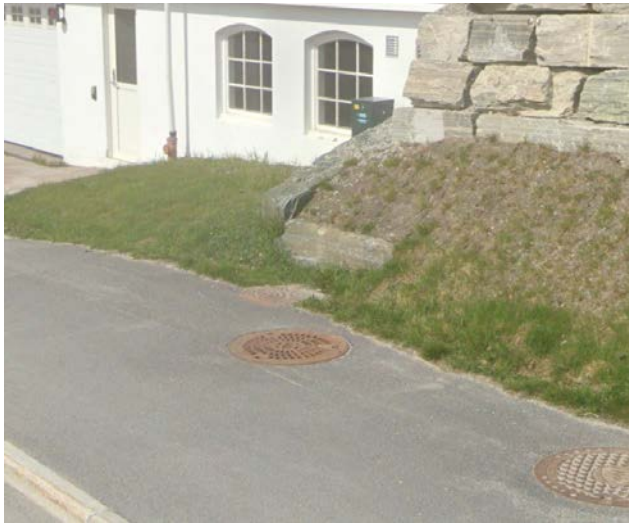
Figur 11 - Eksisterende ristlokk som håndteres dagens avrenning- Utsnitt fra Google Street View
