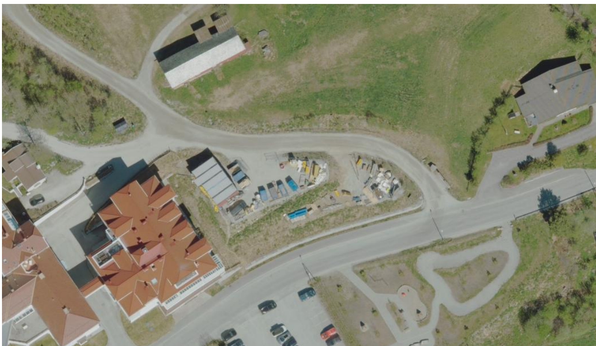
Figur 3 Flyfoto fra 19.05.2025 viser hvordan 64/906 allerede er benyttet som riggområde, før behandlingen av plansaken og utleggelse til offentlig ettersyn
