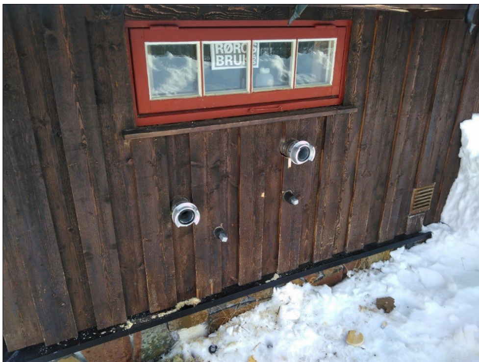
Figur 7.: Eksempel på tappepunkt for brannvann.
