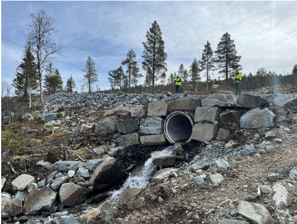
Figur 16 Bilde viser 1 av 5 etablerte kulverter for bekken gjennom området
