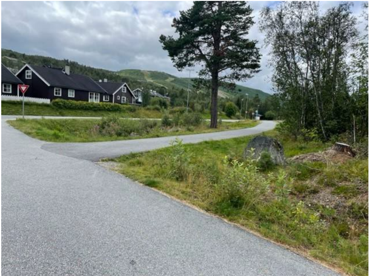
Bilde: Kryss mot hovedveg, gangveg retning Geilo sentrum.
