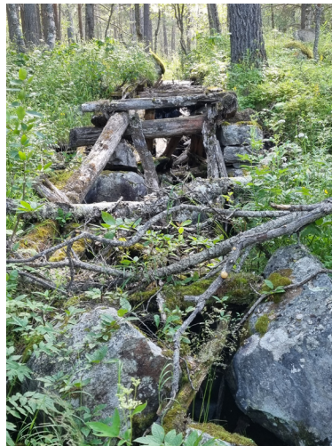
Overgangen fra vasskanalen til vassrenna var om lag 25 meter lang. Foto: Erling Bjørkheim 2024.
