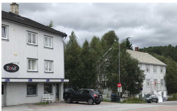
Åkerhuset (23, til venstre) og Slettemoen-bygningen (21, til høyre). Foto: Lars Hamarsbøen 2024.
