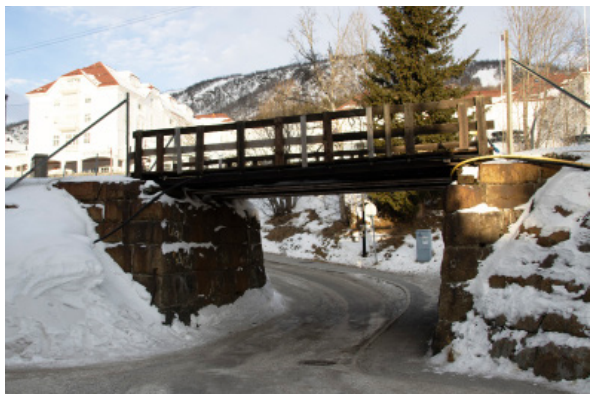
Kulverten under Bergensbanen. Foto: Henning Bergersen 2025.
