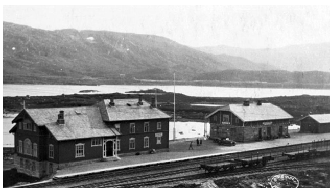
Haugastøl Hotel til venstre og Haugastøl stasjon til høyre i 1913. Foto: Ukjent, Hol Bygdearkiv.
