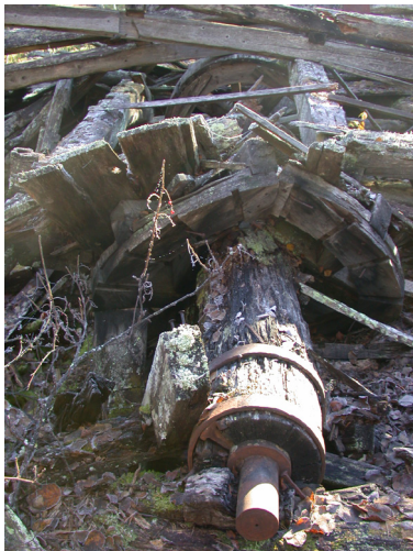
Drivakselen med rester av skovlehjulet, som synes å ha hatt 14 skovler. Lengere inn på akselen sees reimskiva som overførte kraften til sagspindelen via flatreim. Foto: Erling Bjørkheim 2024.
