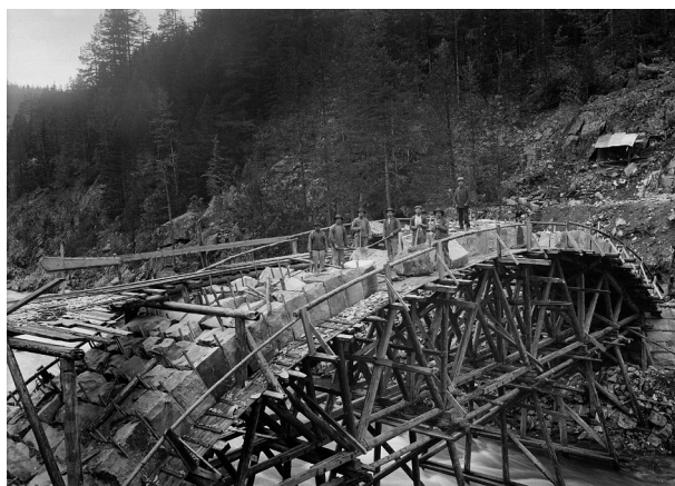
Kvisla bru under bygging, med arbeidslag. Foto: Olav S. Reinton, Hol Bygdearkiv.
