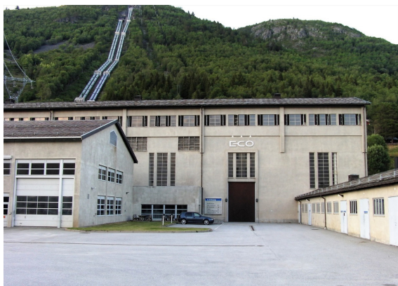
Hol 1 Kraftverk. Foto: Store Norske Leksikon.
