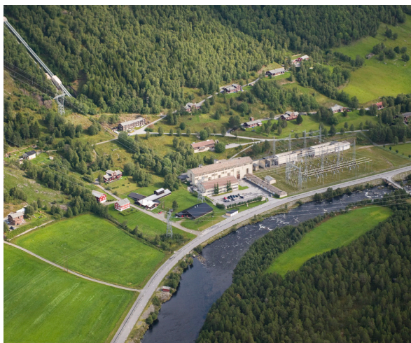
Hol 1 Kraftverk. Foto: Hafslund.
