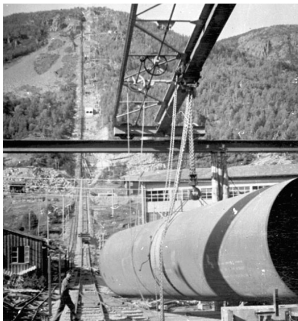
Hol 1 kraftstasjon, deler til rørgate. Foto: Hol Bygdearkiv.
