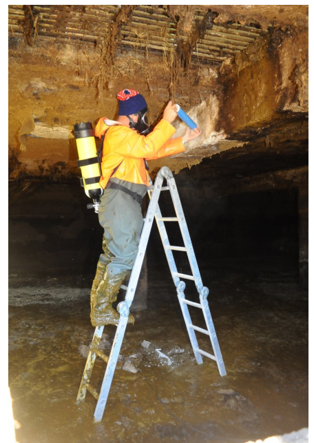
For å fastslå tilstanden på betongen vert det teke slagprøve og bora eit hol eit lite stykke inn i betongen.
