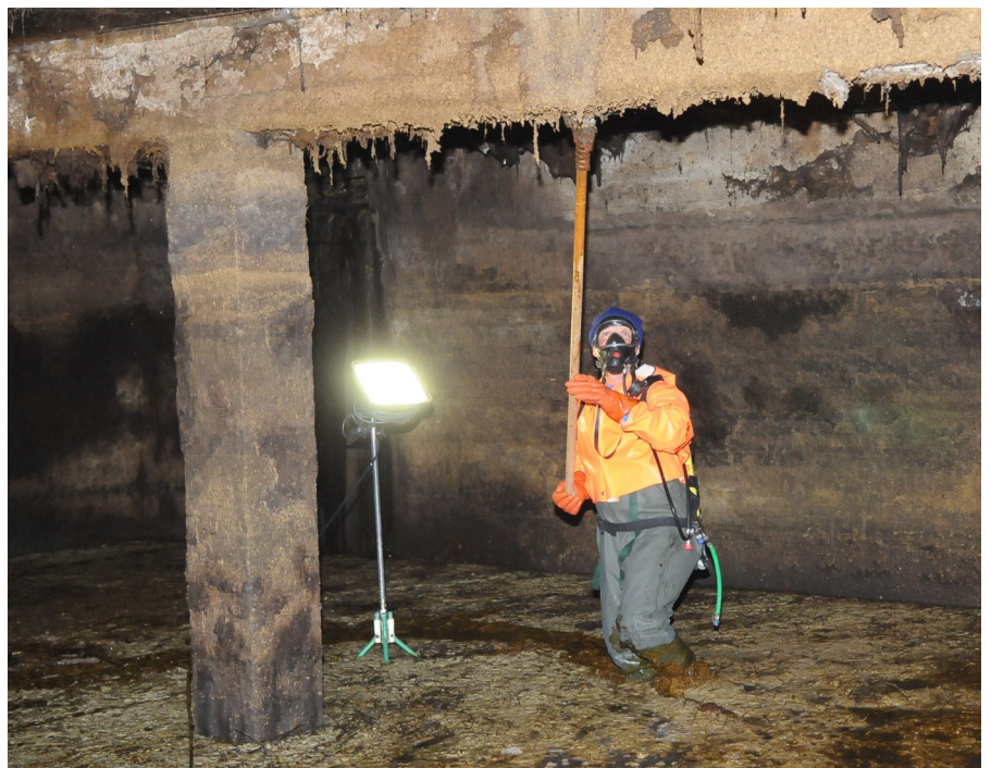
Ein skikkeleg møkkajobb, men naudsynt for å fastslå tilstanden på betongkonstruksjonane i kjellaren.
