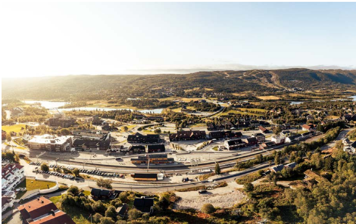
Figur 63 Geilo stasjonsområde (før gangbrua over stasjonsområde). Foto: hentet fra https://www.geilo.com/nb
