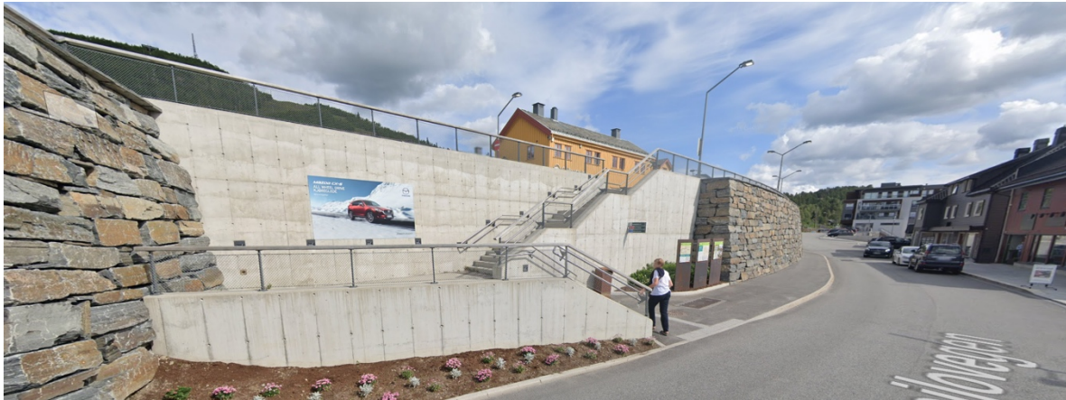
Figur 5: Trapp fra Geilovegen opp til plattform på Geilo stasjon, sett fra vest i Geilovegen (hentet fra Google street view)
