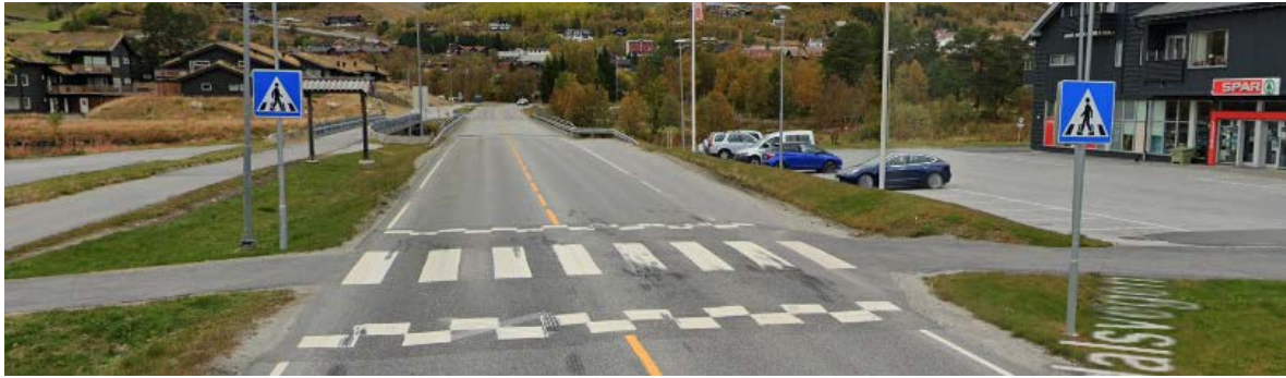
Figur 9: Holdeplassen Vestlia langs fv. 40, sett fra sør (hentet fra Google street view)
