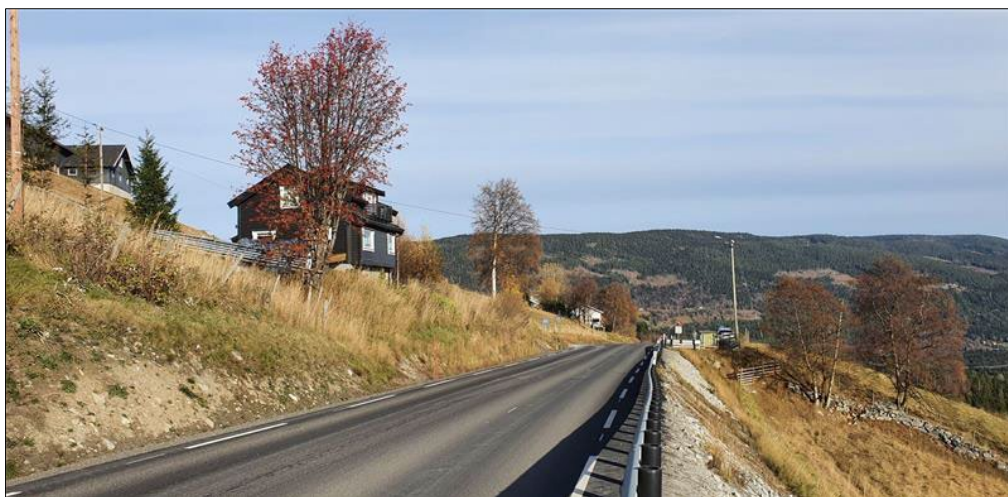
Figur 4-23 Sideterreng langs Rv. 7 ved Søre Kaupang, sett mot øst [befaring 18.10.2021].
