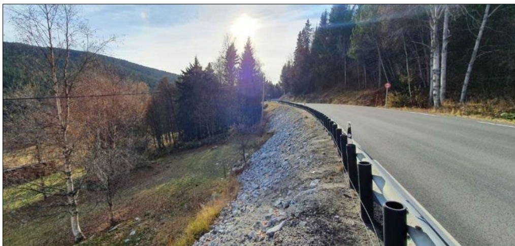
Figur 4-21 Sideterreng langs Rv. 7 ved Nørdre Kaupang, sett mot sør [befaring 18.10.2021].
