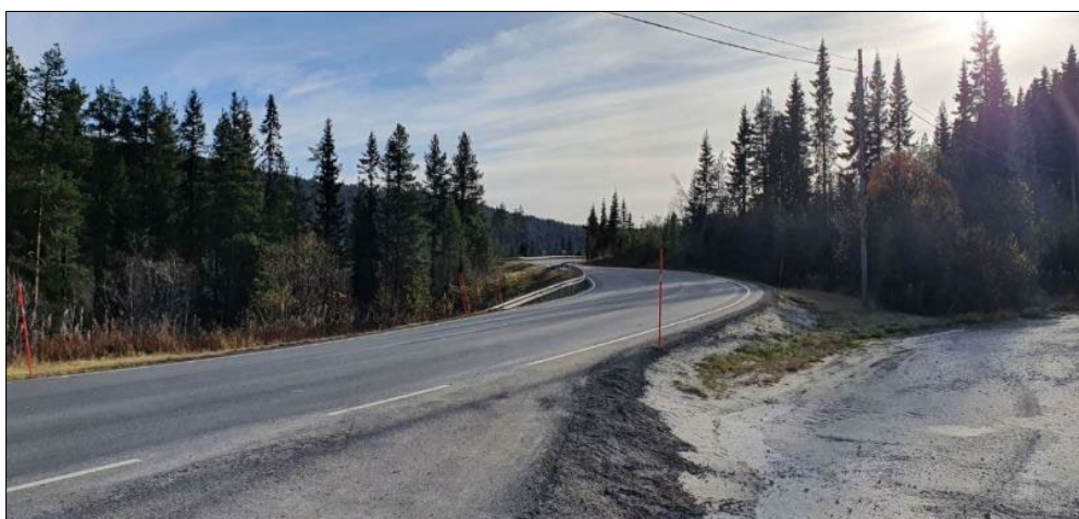
Figur 4-6 Landskapet ved kryss Rv. 7 x Sandsvegen, sett mot sør [befaring 18.10.2021].
