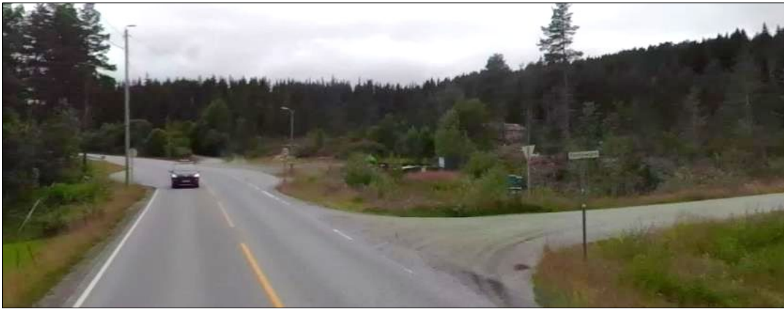
Figur 5-10 Adkomst til Kvisla 107 legges om og kobles på Sandsvegen [Google maps: StreetView].
