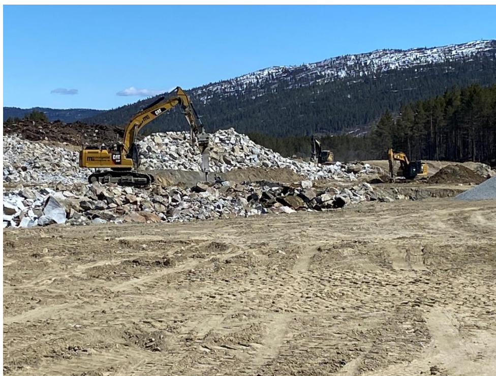
Foto: Hol kommune. Vøllo næringsområde under bygging.
